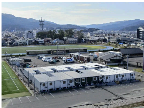
建設された仮設住宅（1月31日、石川県輪島市で）=金沢修撮影
