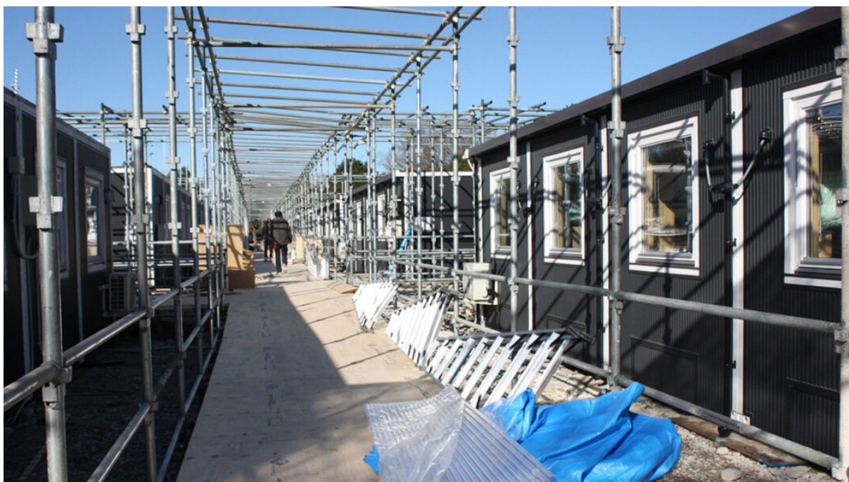
木造の移動式住宅15棟が設置された臨時の医療施設。開所に向け工事が続けられている
