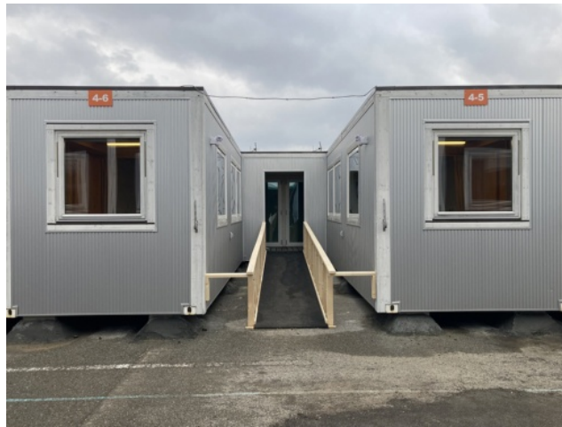
2024年1月31日に石川県輪島市で完成した仮設住宅（写真：石川県） [画像のクリックで拡大表示]
