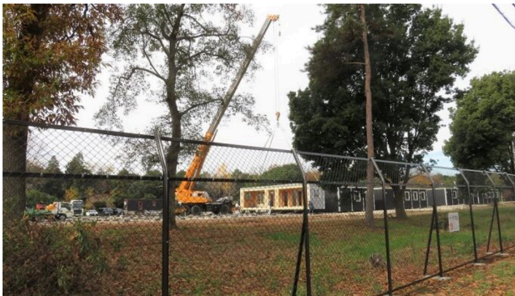
日本財団つくば研究所跡地で建設が進む県の新型コロナ臨時医療施設＝つくば市南原
