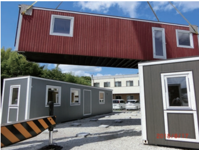
災害救助法の要請により倉敷市で初めて仮設住宅として採用されたトレーラーハウスの設置風景（画像提供：アーキビジョン21）
