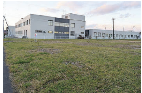
鷓川高校野球部寮の仮設寮が建設される空き地
