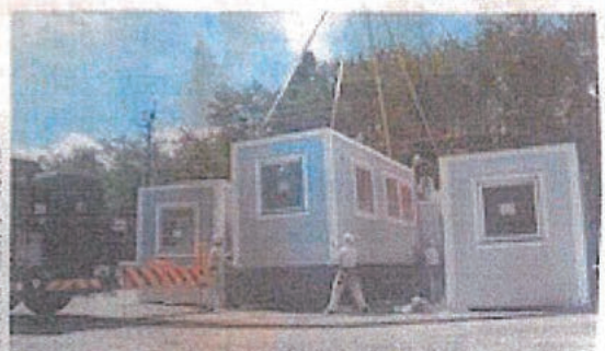
クレーンでつり上げて設置される移動式木造住宅＝22日、球磨村
