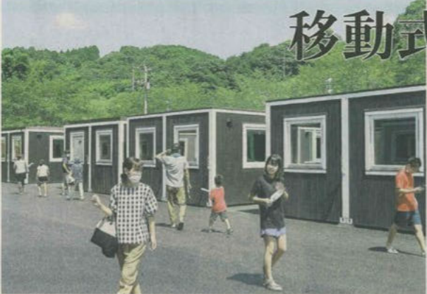
球磨村の総合運動公園内に設置された、トレーラーで運搬可能な「ムーピングハウス」の仮設住宅=2020年8月
