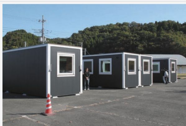
入居が始まった移動式の仮設住宅
