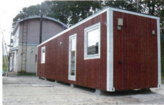
被災地に建設したスマートモジュール＝アーキビジョン21提供
