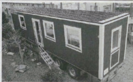
2月21日に岩手県陸前高田で、次世代型の応急仮設住宅が披露された
