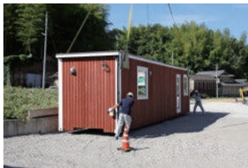
設置される仮設住宅用トレーラーハウス（8日、岡山県倉敷市）
