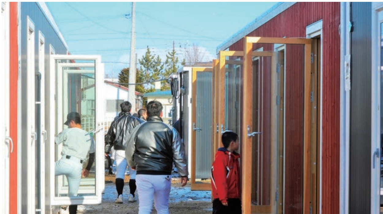
仮設寮の部員居室。完成時には両棟をつなぐ屋根付き廊下が設置される
