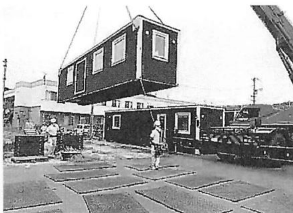
移設のためつり上げられるムービングハウス（9日、アーキビジョン21提供）
