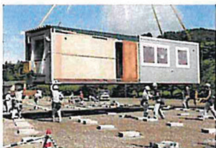
熊本県球磨村で始まった仮設住宅の設置作業＝22日午前
