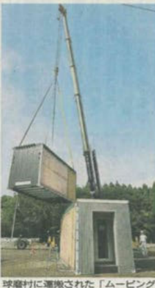
球磨村に運搬された「ムーピングハウス」の仮設住宅=2020年7月
