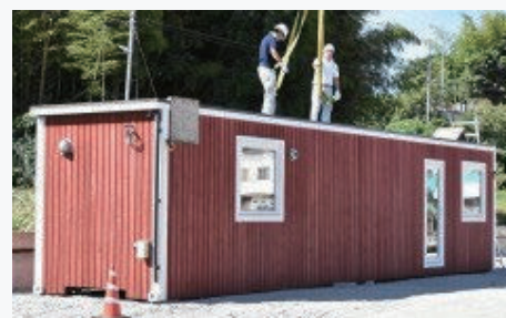
モデルハウス用に設置されたトレーラーハウス型仮設住宅＝8日午前8時45分、倉敷市船穂町柳井原
