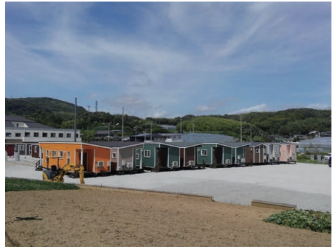
倉敷市船穂町柳井原地区の仮設住宅団地にて、大型トレーラーハウスの設置風景（画像提供：カンバーランドジャパン）
