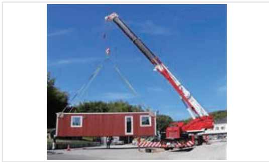
クレーン車で設置作業が進む仮設住宅用トレーラーハウス＝倉敷市
