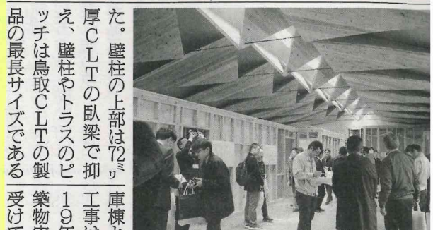
事務所棟の3Dトラス(中央上三角形のCLTを手加工した
