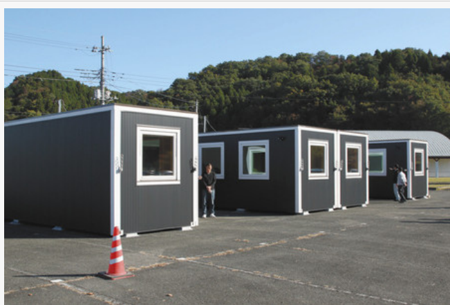
入居が始まった移動式の仮設住宅
